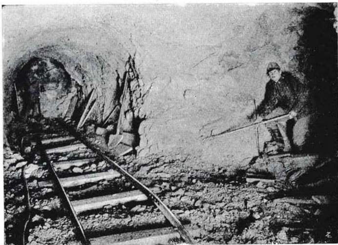
Attacco frontale della Galleria Bertarelli dal lato della Grotta Nera. Questa Galleria unirà la Grotta Nera alle Grotte di Postumia. Sarà lunga 455 metri circa, ne rimangono da perforare circa 90.
