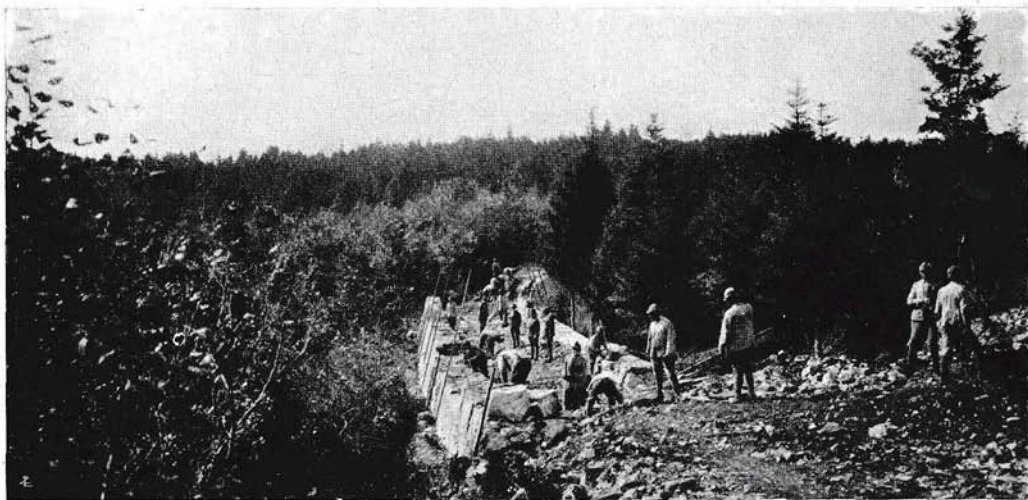
Un rilevato in pietre della strada della Grotta Nera attualmente in costruzione.
