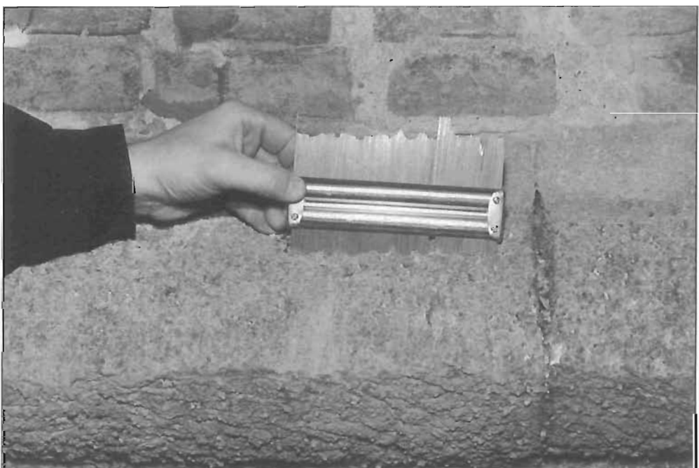
Fig. 7 - Misura della larghezza e della profondità dei karen sviluppatisi nei gessi sopra il cordolo di gesso del basamento della torre Garisenda negli ultimi 110 anni.
