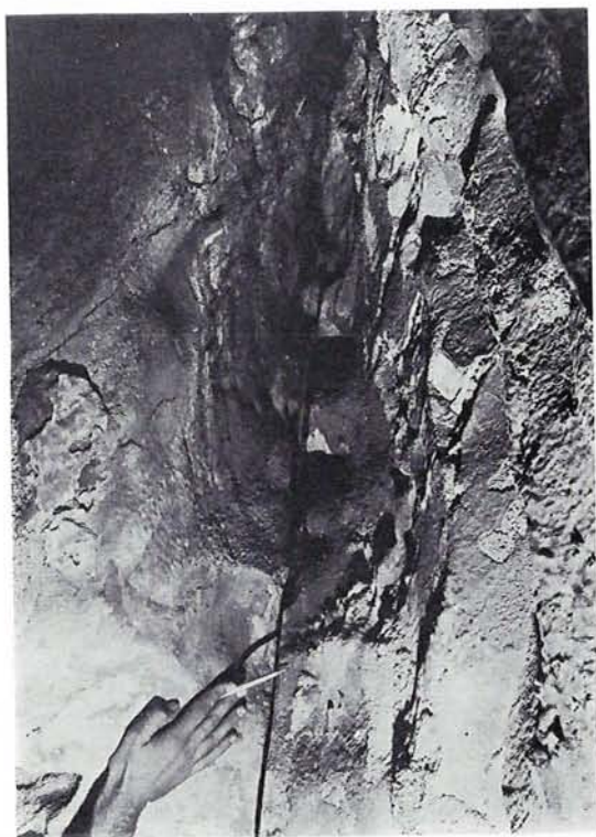
FIG. 4 — Serie di cupole di corrosione con piano di frattura interessato dallo spostamento; il blocco a destra si è spostato in basso e verso l'osservatore
