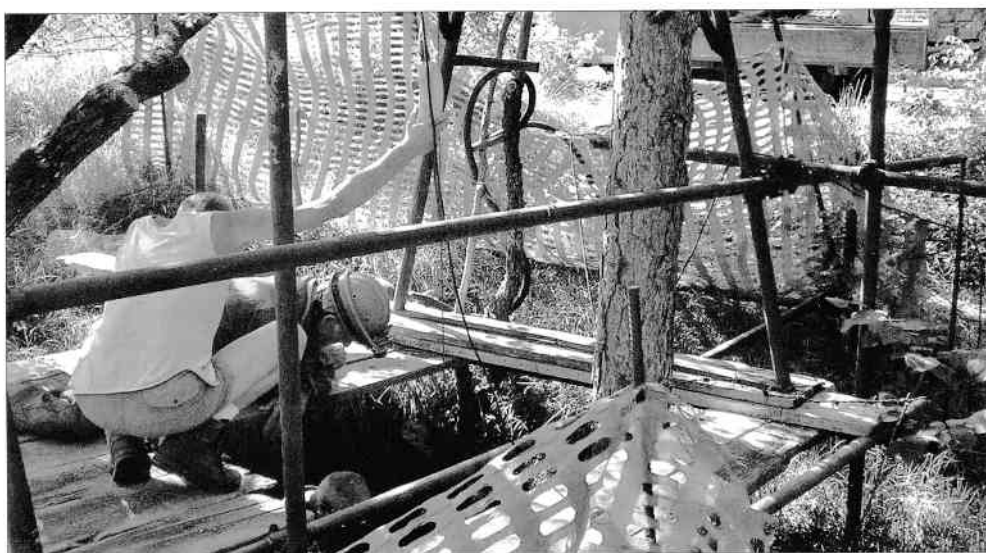
Panoramica del cantiere
