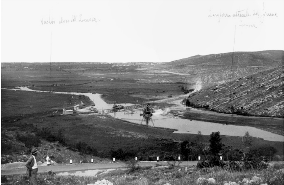
La piana del Lisert durante i lavori di allargamento del Locovaz (Archivio Storico del Consorzio di bonifica Pianura Isontina).
