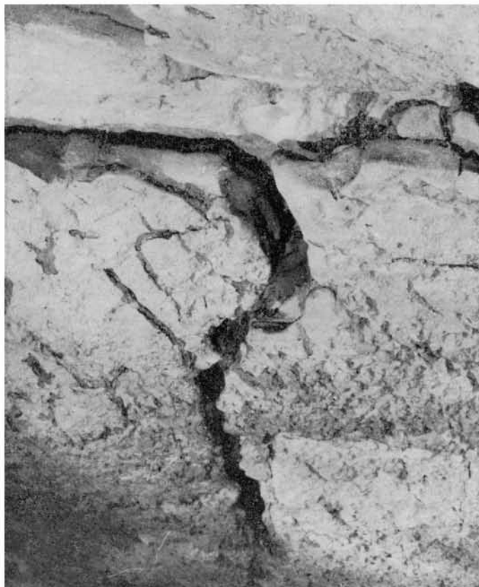
FOTO 3 — Canale di volta nella parte inferiore della cavità.
