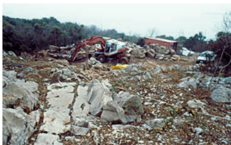
Fig. 4 - Il sito all'inizio della rimozione meccanica dei blocchi, pulito dalla vegetazione e dalla terra, foto Sergio Dolce.
