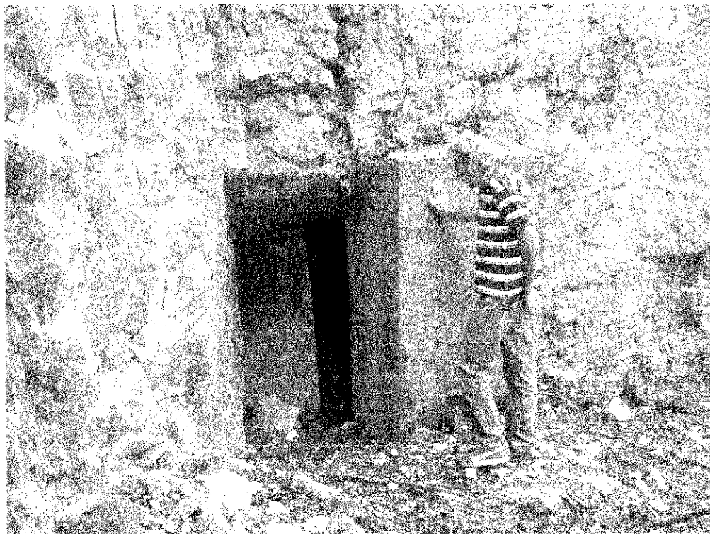
Ingresso di una caverna – bunker nel Promontorio Bràtina.
