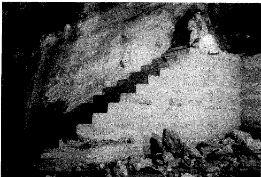
La scala che porta al primo grande ripiano; le due successive terminano sulla china formata dallo scarico del materiale scavato nelle zone superiori.
