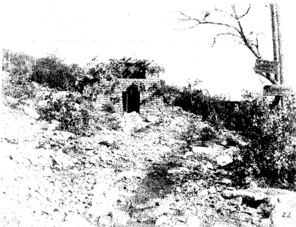
La costruzione in pietra sopra l'ingresso naturale della Grotta del Motore durante la Grande Guerra (coll. P. Russian).
