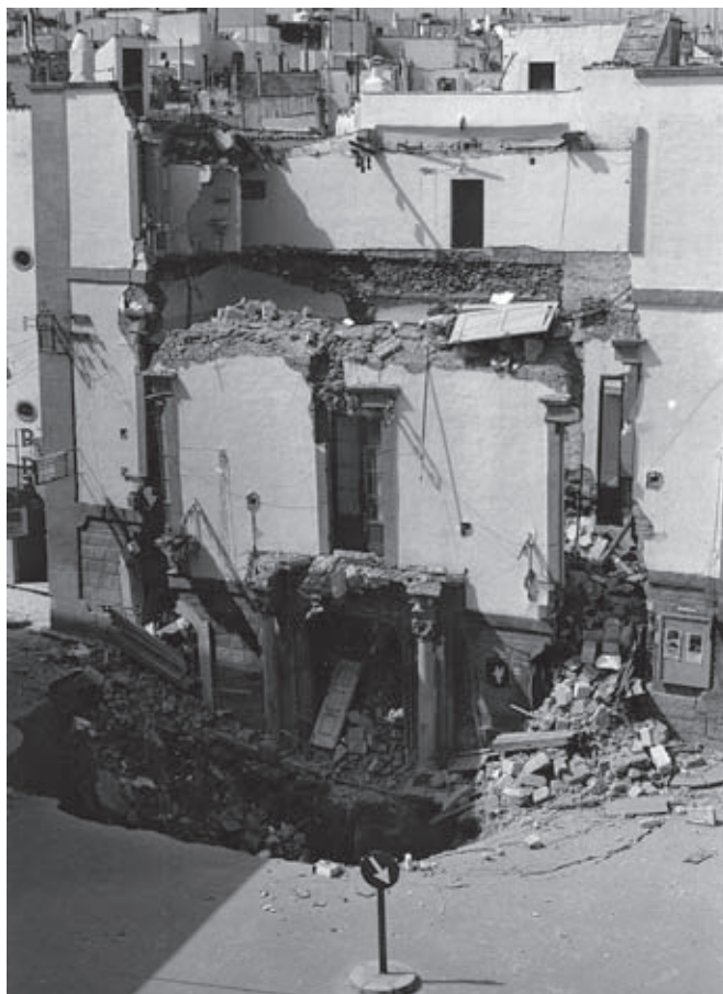
Fig. 5 – Sprofondamento di Largo Porta Grande, avvenuto nel settembre 1968 (foto: G. Campanella).
