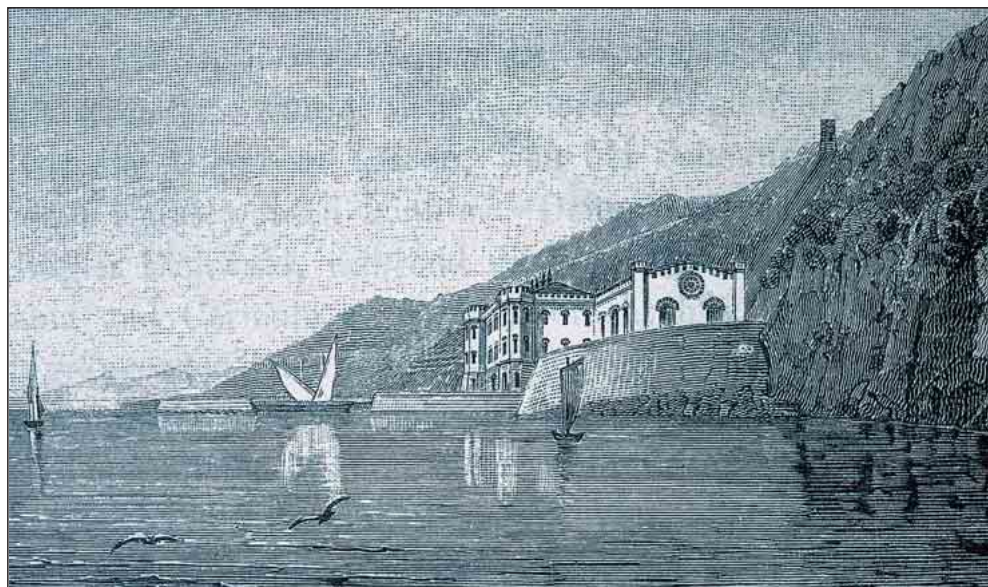
Fig. 5 - Maschinenhaus der Wasserleitung bei Auresina. (NOE. Oesterreichische Südbahn. Von der Donau zur Adria ... Zurigo, s.d.).
